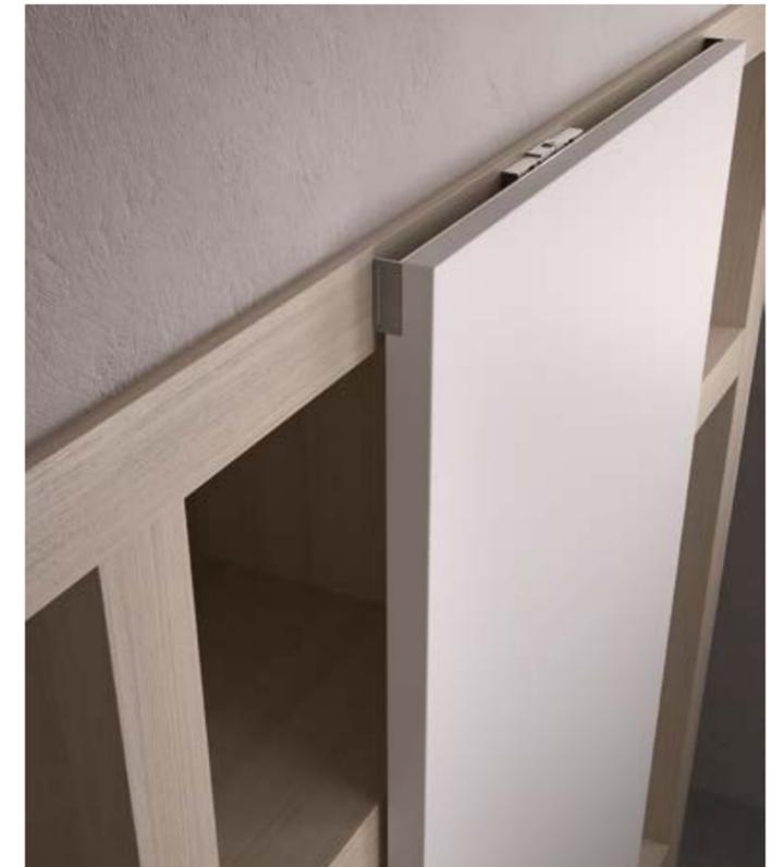
Mithilfe von Teleskopschienen oder Gleitführungen gleitet die Tür parallel zur Wand oder überlappt wie in dieser Lösung ein hölzernes Bücherregal. Für die Montage sind keine Maurerarbeiten erforderlich und das Ergebnis ist sehr dekorativ.
